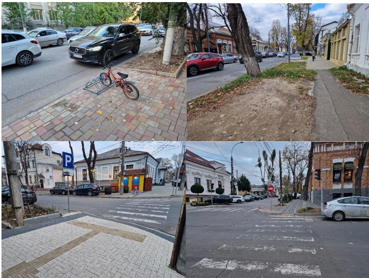
FIGURA 58. TROTUARE DEGRADATE ȘI DIFERITE MODELE DE MODERNIZARE - CHIȘINĂU CENTRU
